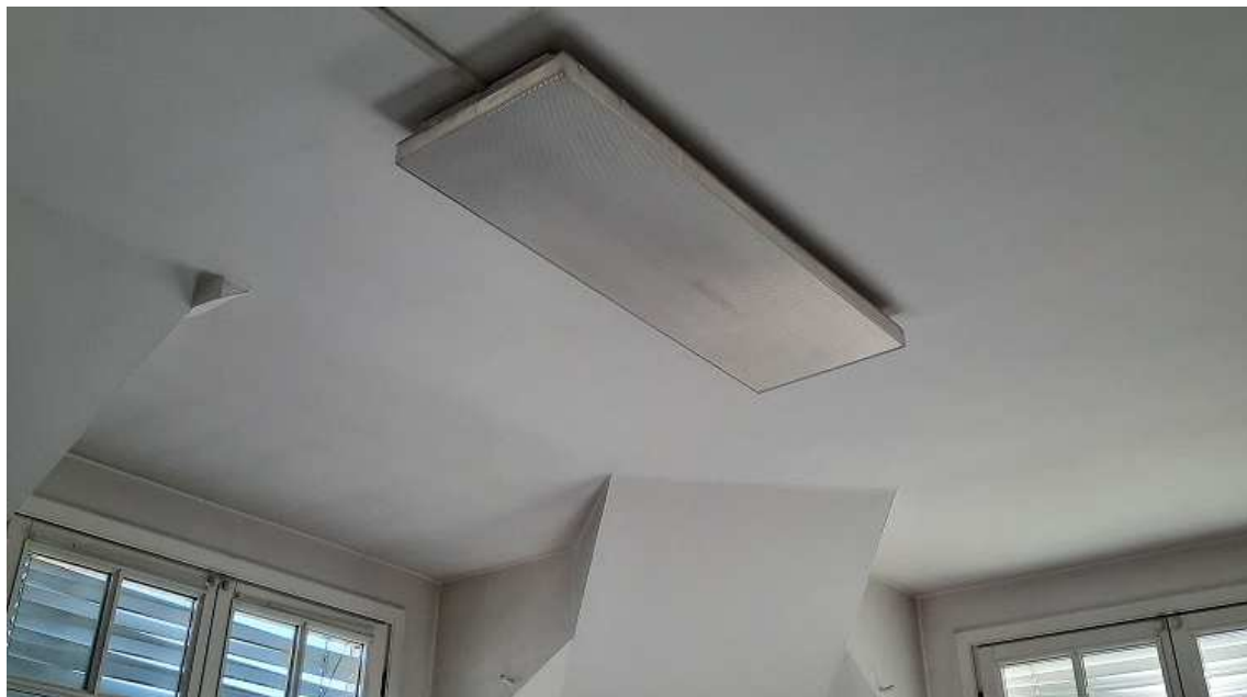
foto 1- tipologia di lampada installata negli uffici
