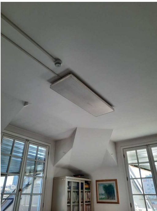
Piano terzo – uffici
