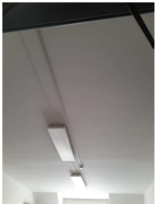
Piano terzo - uffici
