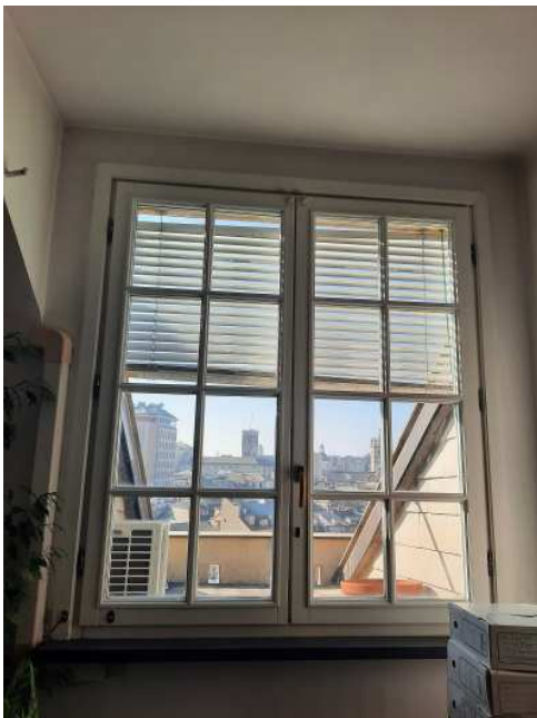
Finestra Piano terzo in alluminio taglio termico e legno
