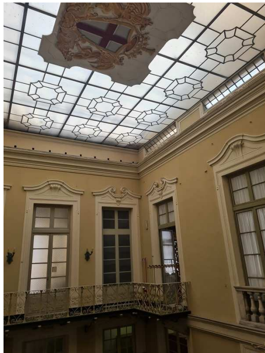
vista del velario dal cortile del Piano terra
